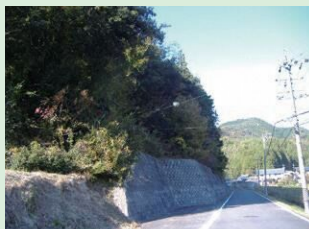
2-② バッファーズーン整備前
