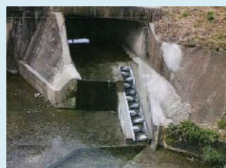
9-③ 用排水路・河川落差解消後
