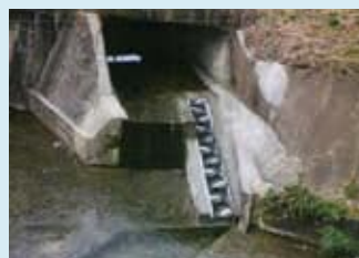
9-③ 用排水路・河川落差解消後
