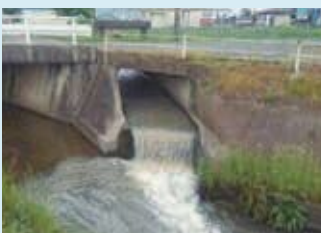
9-③ 用排水路・河川落差解消前
