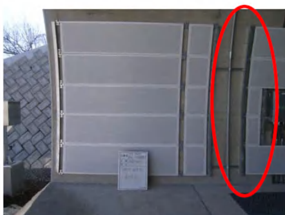
(内装板の設置ができない事例)
