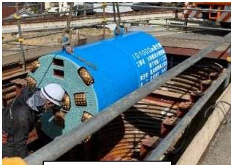
推進工事（恵那市内）
