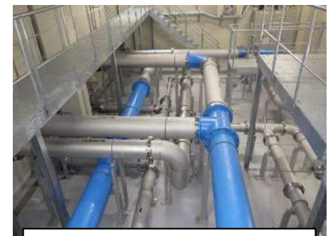
所内配管の整備状況（中津川市内）
