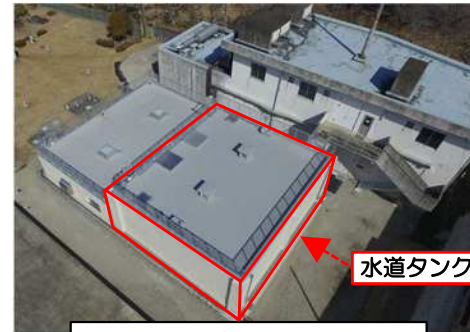
ポンプ所全景（中津川市内）
