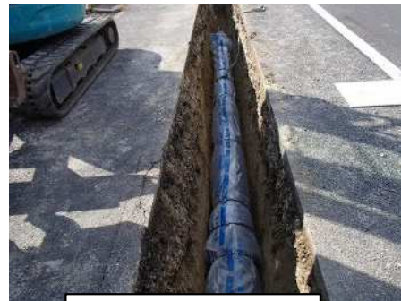
開削工事（中津川市内）
