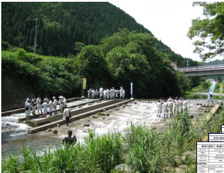
魚道カルテを用いた点検状況 (小駄良川(郡上市))
