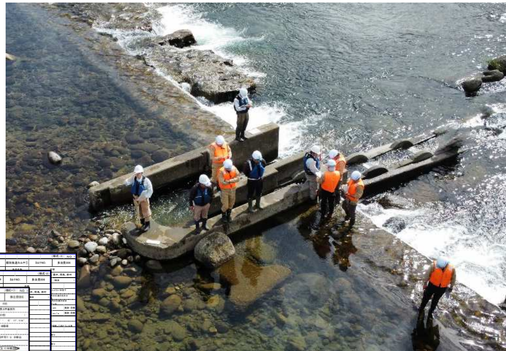
魚道カルテを用いた点検状況 (長良川(郡上市白鳥町))
