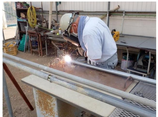
防風ネットの支柱の溶接作業
