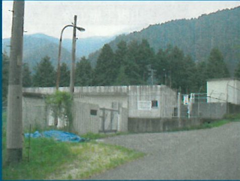
簡易水道施設
