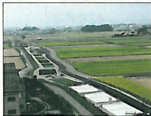
(a)沈殿+植生浄化
