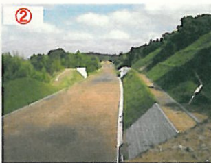
② <小迫間:施工中>
