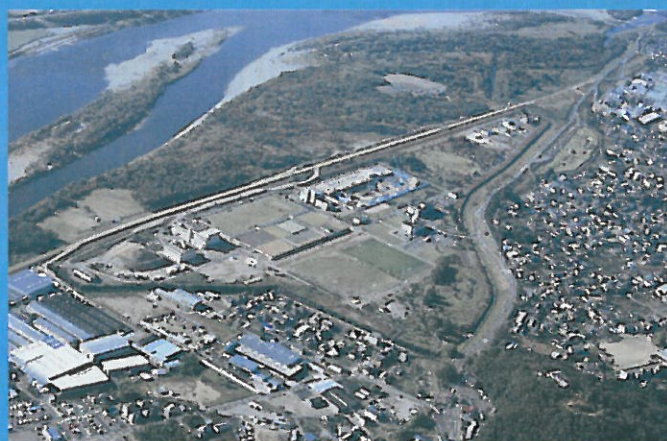
岐阜県各務原浄化センター
