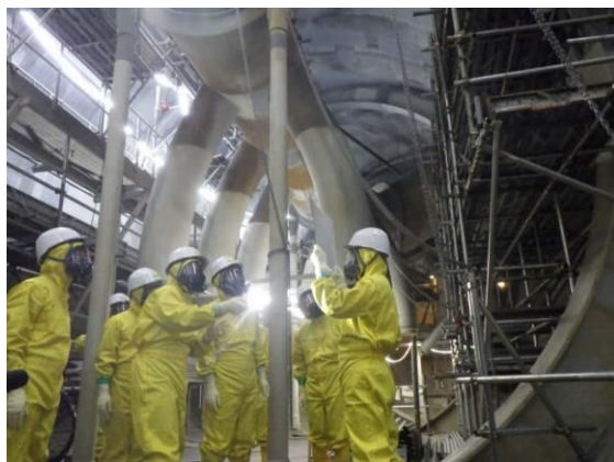
現地視察の様子 (1、2 号機の廃止措置状況)
