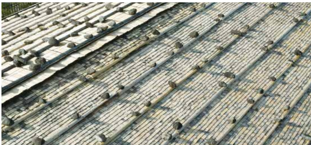
御蔵の屋根をドローンから見る。たくさんの重石が置かれているのが分かる。
