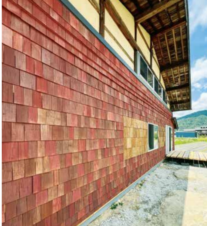
川上舟晴さんが改修を手掛けた古民家と樽板の壁
