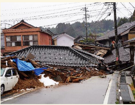
多くの住宅が倒壊した状況
