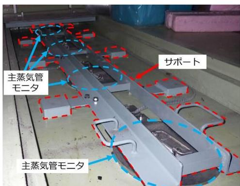
主蒸気管モニタの地震による浮き上がり防止のため
