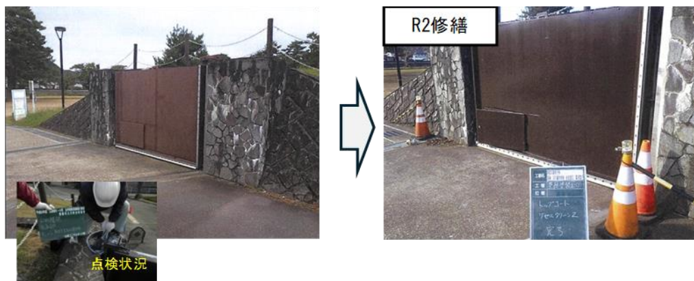
図-1.10 陸閘修繕状況
