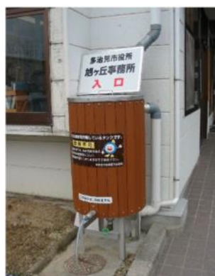
貯留・浸透施設の設置
