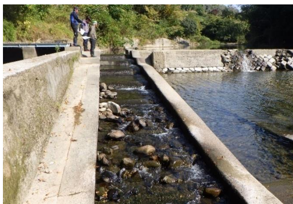
フィッシュウェイ誌ターによる魚道点検の実施
