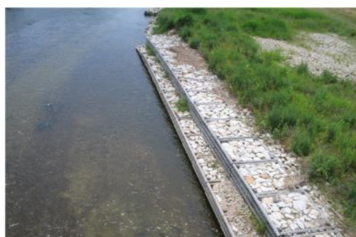
図- 3.7 木工沈床の整備 (土岐市土岐津町)
