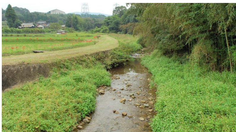
図- 3.5 土岐川での改修事例－２（恵那市武並町竹折）
