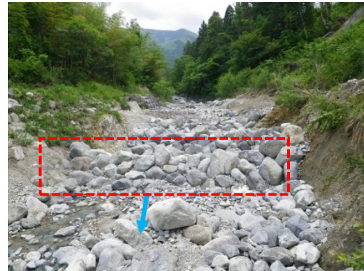
施工直後（石組み落差工）
