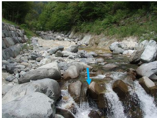
施工前（河床低下の進行）
