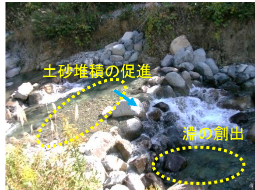
施工後（5ヶ月後）
