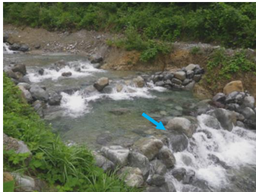
施工後（出水後）
