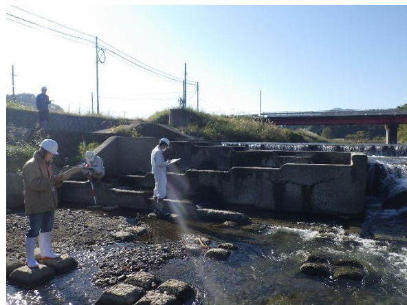
フィッシュウェイプレートによる魚道点検の状況
