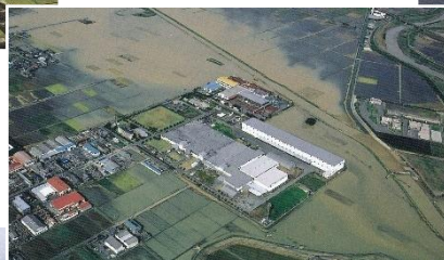
養老町室原地区の 浸水状況
