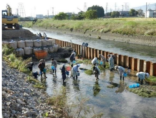
工事中の生物保護活動（杭瀬川）
