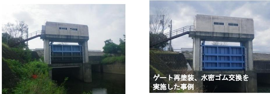
図- 1.22 河川構造物の老朽化対策
