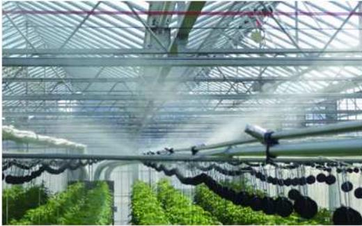
図 18 細霧冷房による高温対策
