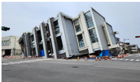
〔倒壊したビル〕
