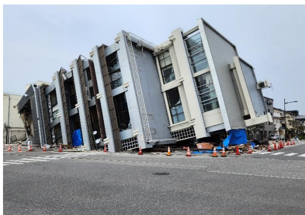
倒壊したビル
