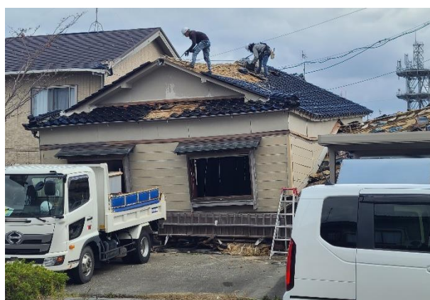
解体中の被災家屋
