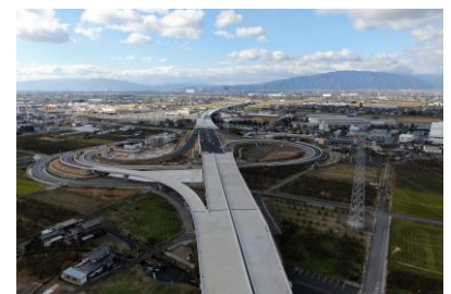
[東海環状自動車道 本巢IC周辺状況]
