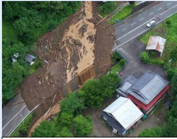
国道158号での土砂災害
