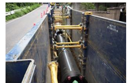
[水道耐震管の施工状況]
