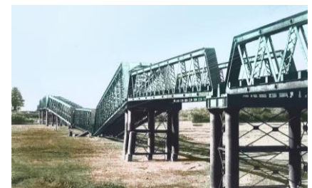
〔長良川(岐阜-穂積)鉄橋崩壊〕 （岐阜県歴史資料館 原画提供）
