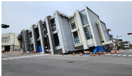
[倒壊したビル]
