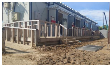
[浸水した応急仮設住宅]
