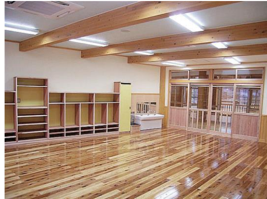
スギの圧縮材を利用した事例
