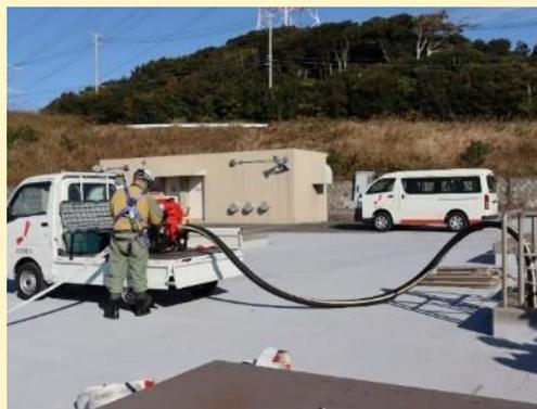
緊急時淡水貯槽からの取水の様子
