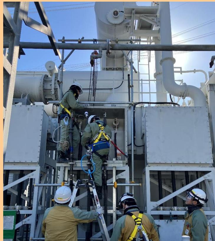
浜岡原子力発電所構内での外部電源復旧訓練
