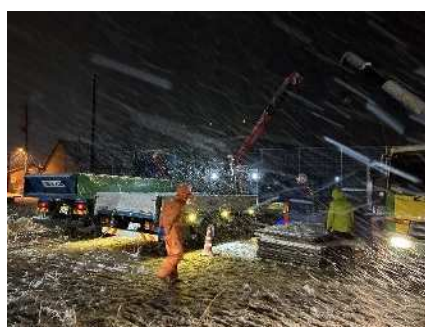
備蓄資機材の搬入 (岐阜県建設業協会)
