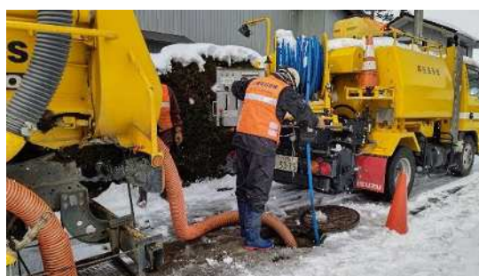
下水道二次調査 (石川県中能登町)
