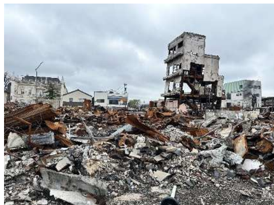
火災被害の状況 (石川県輪島市)
