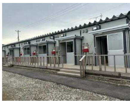
仮設住宅 (石川県輪島市)
