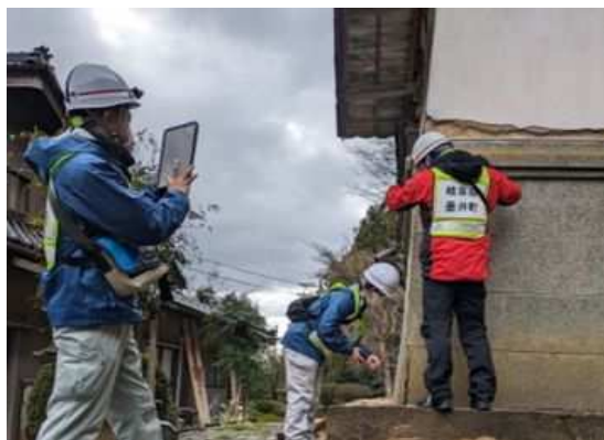
タブレット端末を活用した住家被害調査 (石川県中能登町)
