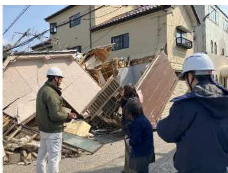
解体工事の立会 (石川県輪島市)
