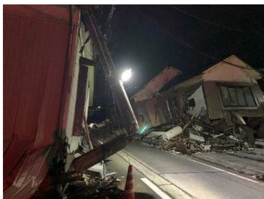
家屋被害の状況 (石川県輪島市)
