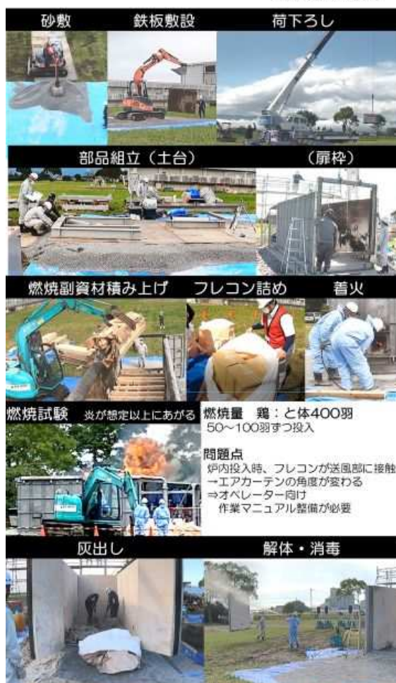
図3. 移動式焼却炉の実働演習（作業工程）
