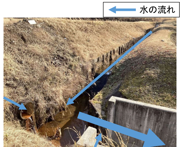
⑥3つの水路の合流箇所
