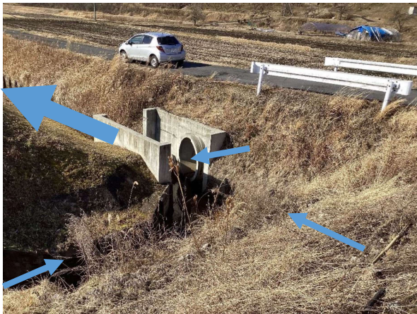
⑦3つの水路の合流箇所
