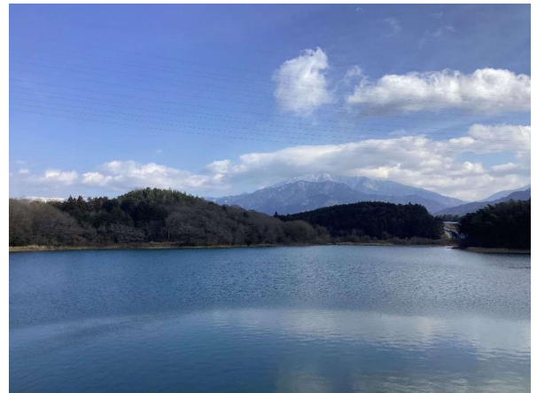
②堤体から旧ため池を望む
