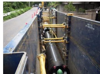
▲水道耐震管の施工状況
