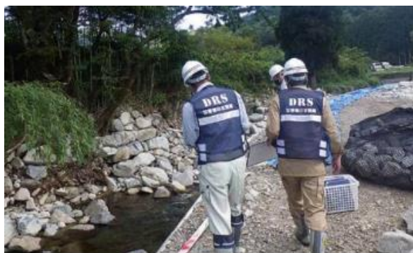
下呂市内 河川災 現地調査の様子
