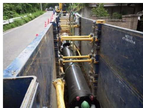
水道耐震管の施工状況
