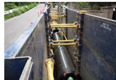
〔水道耐震管の施工状況〕
