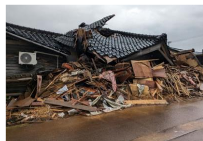
〔地震により倒壊する木造住宅 (石川県中能登町)〕
