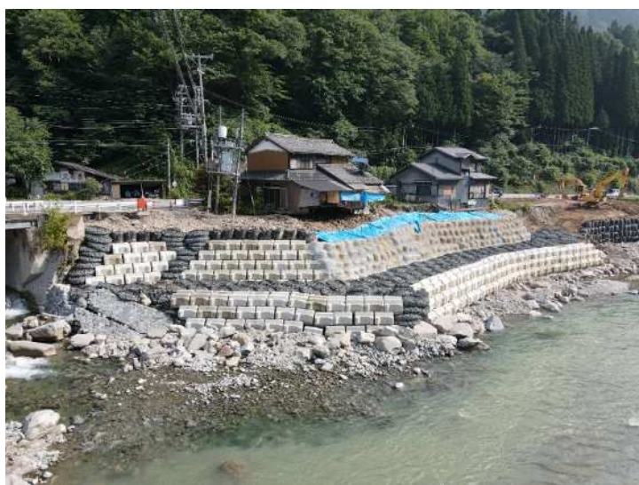
応急工事完了後
