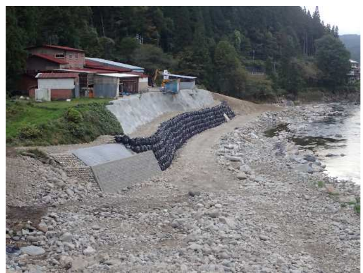
応急工事完了後
