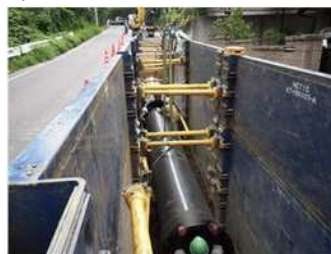
▲水道耐震管の施工状況
