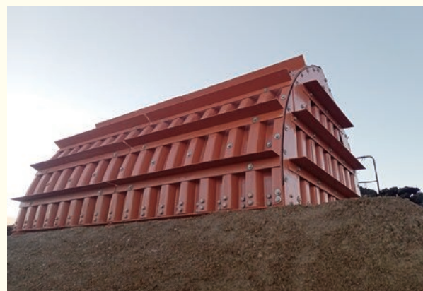
新たに設置されたシエルター
