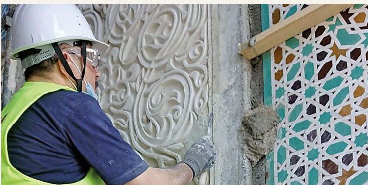
木工細工の 取り付け作業
