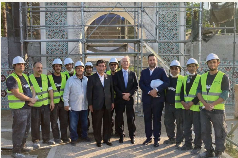
■2022年4月、モロッコ王国の伝統技術を受け継ぐ熟練の技術者10名と建築家が来日し、約50日間にわたり施設整備
