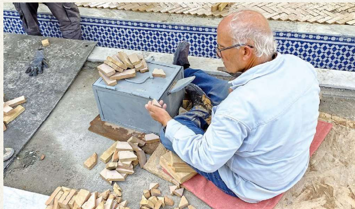
ベジュマツト (床面タイル)の 貼り付け作業
