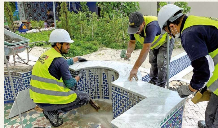
噴水に大理石の板を取り付ける作業
