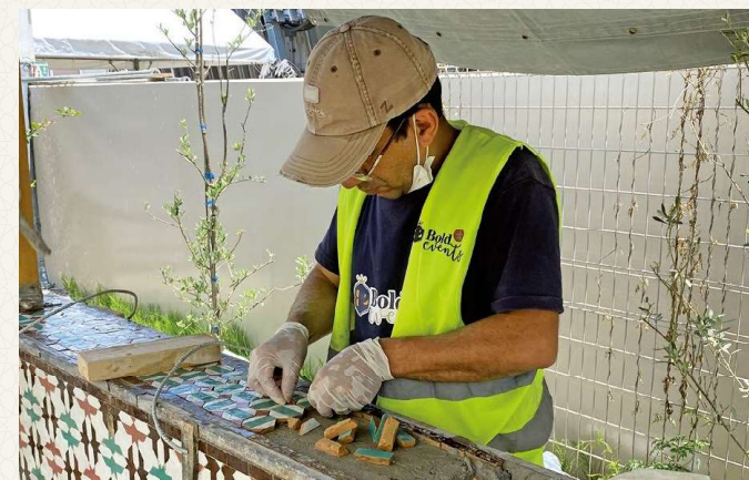
ゼリージュ (モザイクタイル)の 組み合わせ作業
