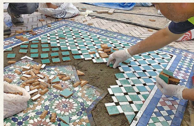
ゼリージュ (モザイクタイル)の 組み合わせ作業
