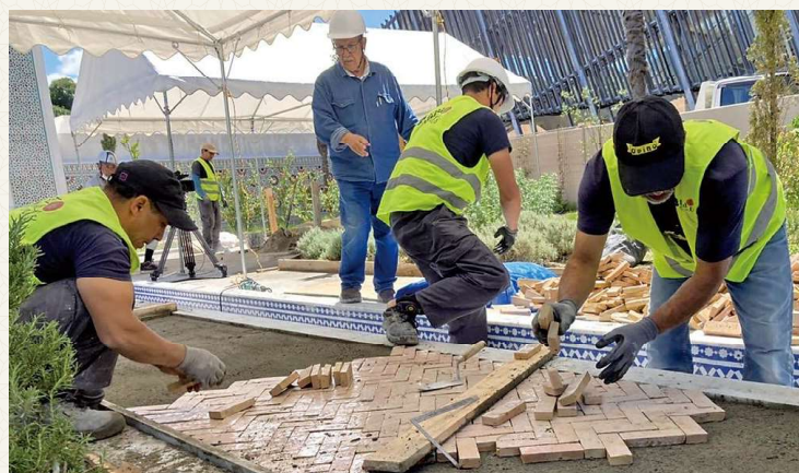
ベジュマツト (床面タイル)の 貼り付け作業
