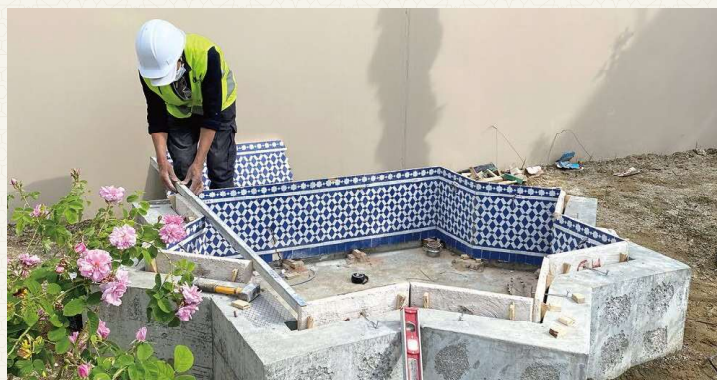
噴水にゼリージュ (モザイクタイル)を 貼り付ける作業
