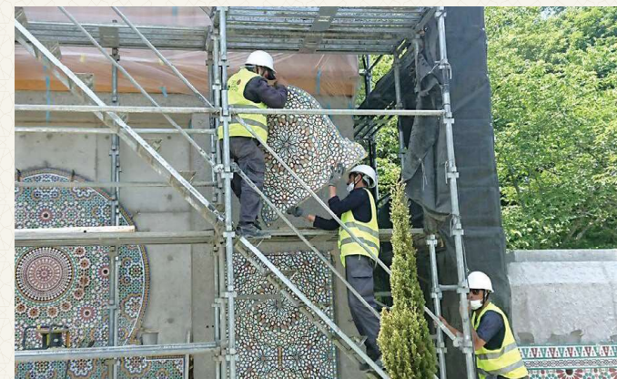
噴水に大理石の板を取り付ける作業
