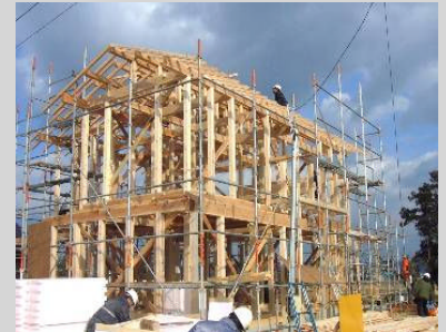
県産材住宅の上棟
