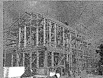
県産材住宅の上棟
