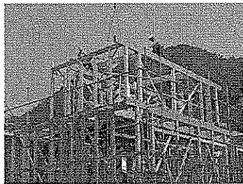
県産材住宅の上棟
