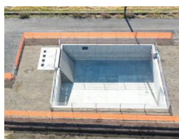
経営体 揚水機場
