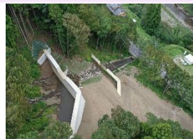
治山事業 谷止工
