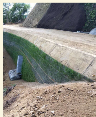
図7 フォートラックRS工法 （令和5年8月 撮影）
