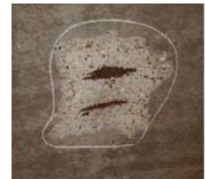
近接して計測した鉄筋露出の範囲 500mm×500mm
