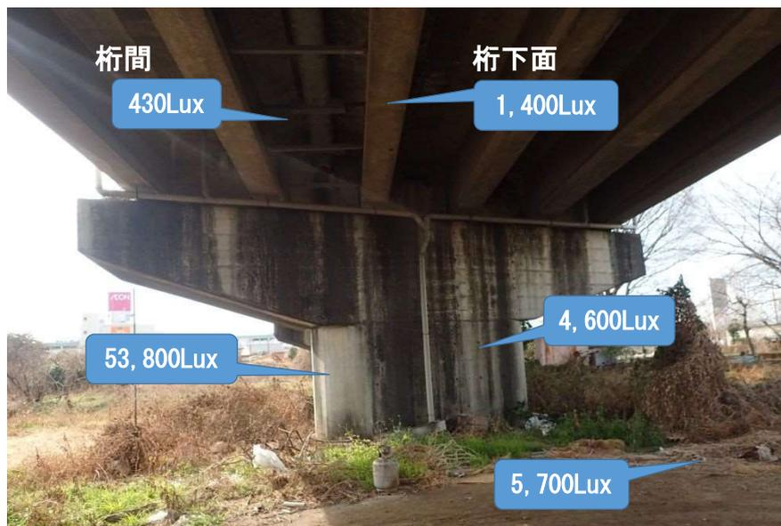
付録3-図3.1 ポステンT桁橋下面の照度計測値
