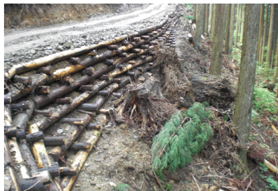
明石1号線丸太組工
