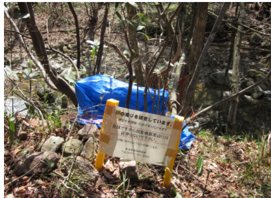
濁度計設置状況
