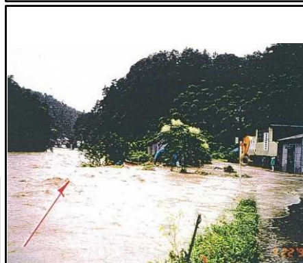
下之保地区浸水状況
