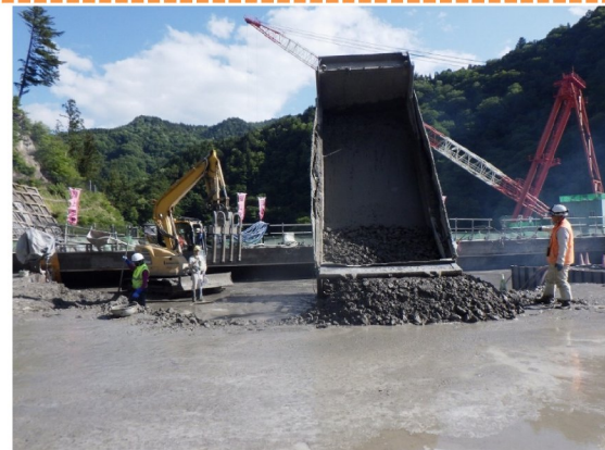
堤体打設(ダンプ搬入)
