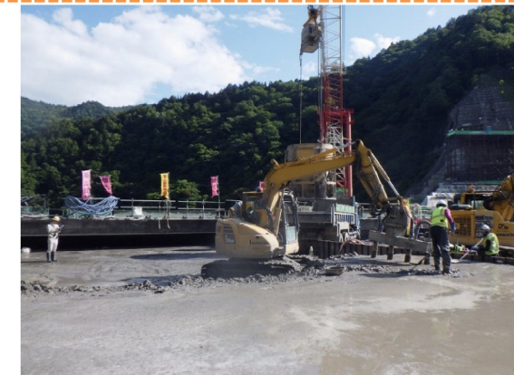
堤体打設(バイバック締め)
