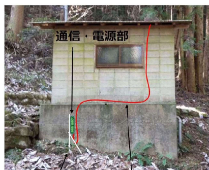
支柱 (単管パイプ)
