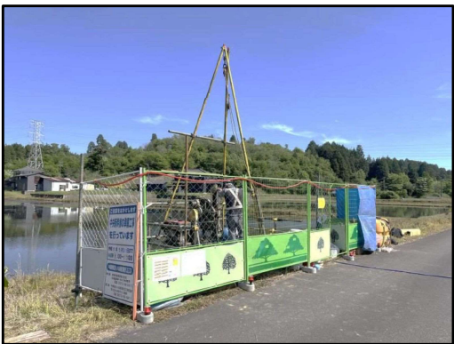
観測井4(設置工事中の写真)
