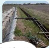
魚が水田に入ってこられるように、水田と用水路の高低差をなくす人工の水路「水田魚道」を作ることが全国的に推奨されています。ここではさらに、水田の一部を溝状に掘り下げていつでも水が溜まるようにし、水田から水が抜かれるときに魚が退避できる場所を作っています。長良川ではありませんが、河口で長良川と合流する揖斐川の支流です。
