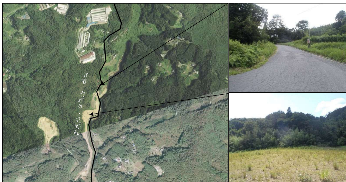
図 2-2-2(4) 南垣外非常口北側の状況
