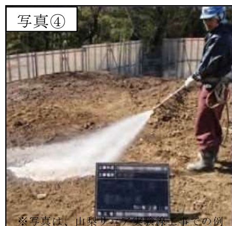
発生土の散水状況
