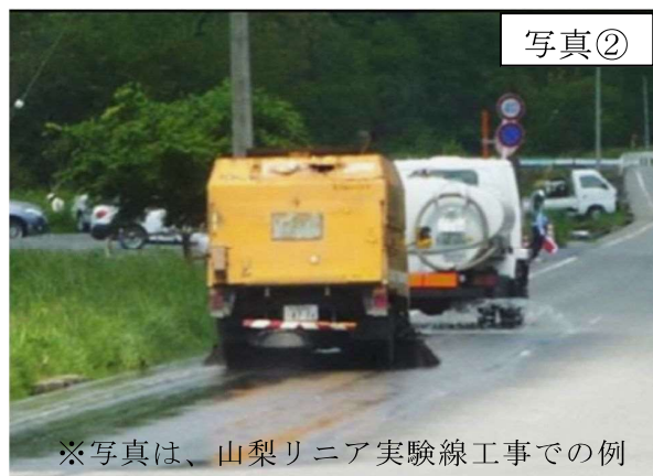
道路の散水状況
