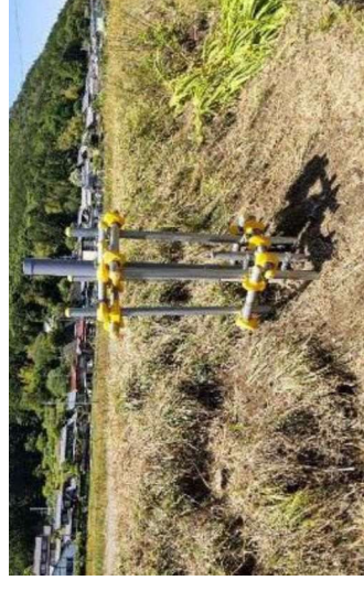
③観測井4の設置状況
