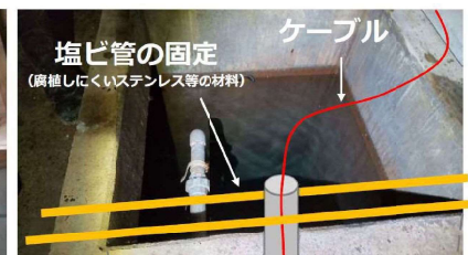
塩ビ管 （スリット加工）
